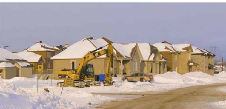
Faubourg Le Raphaël en construction.
